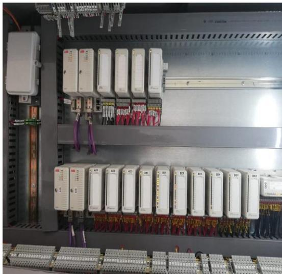
**Fig 12. Tablero de conexión PLC y módulos de comunicación**
