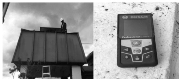
Figura 8: Personal autorizado y equipo de medición laser
